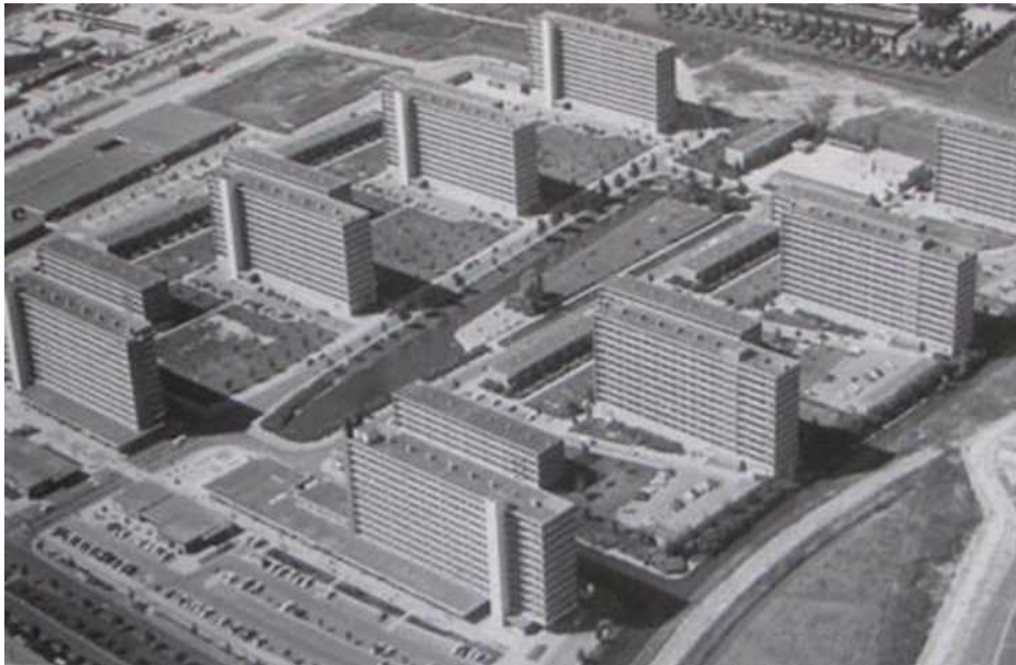
<그림 36> 포트호프 건설 초기 현황
