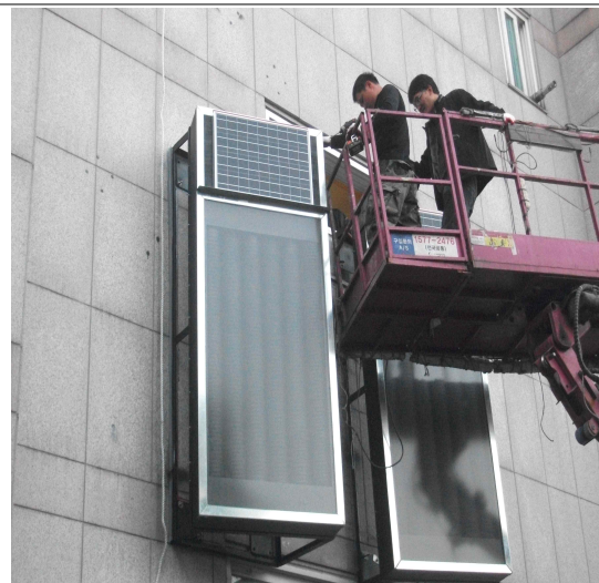
'성대골마을학교 겨울나기' 프로젝트 - 태양열온풍기 설치
