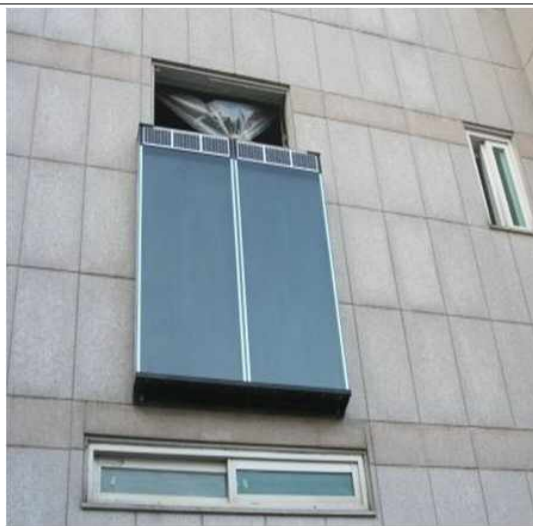
'성대골마을학교 겨울나기' 프로젝트 - 태양열온풍기 설치
