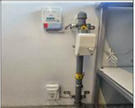
가스 및 안전장치 설치
